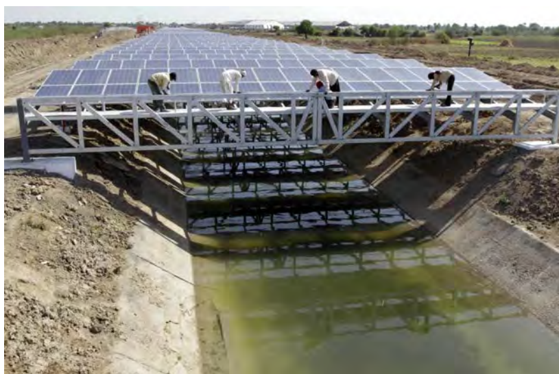
Protejarea canalelor de irigații cu panouri fotovoltaice
