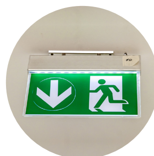
ILUMINAT DE SIGURANTA
